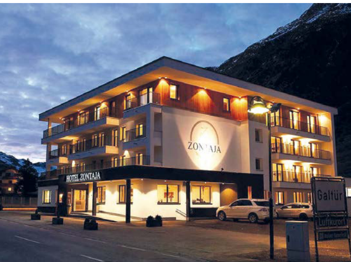
Der Neubau bzw. die Renovierung des Hotels Zontaja in Galtür (Tirol) wurde im Herbst 2016 mit comSCHÄCKE überprüft.
